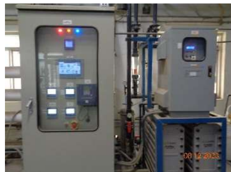
รูปที่ 2-41 ระบบ EDI (Electrodeionization)
