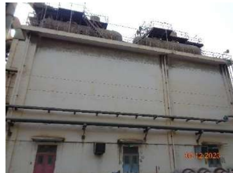
รูปที่ 2-34 อาคารปิดคลุมเครื่องจักรที่มีเสียงดังภายในพื้นที่โรงงาน 3 (สายการผลิตที่ 5 และ 6)
