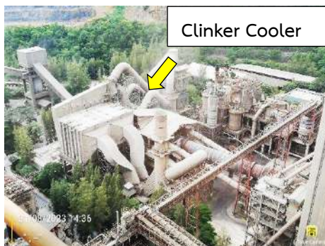
รูปที่ 2-29 ท่อนำลมร้อนทั้งจาก P/H Boiler และ Clinker Cooler โรงงาน 3 (สายการผลิตที่ 5 และ 6)
