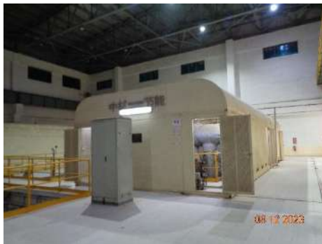
รูปที่ 2-34 อาคารปิดคลุมเครื่องจักรที่มีเสียงดังภายในพื้นที่โรงงาน 3 (สายการผลิตที่ 5 และ 6)
