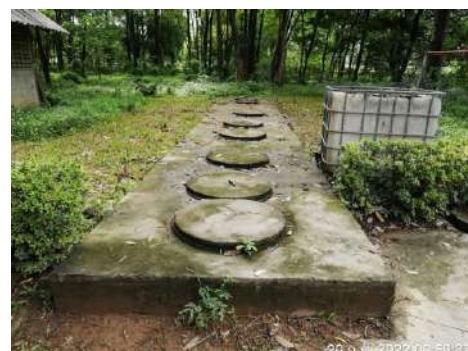
รูปที่ 2-10 ถังบำบัดน้ำเสีย (Septic tank)
